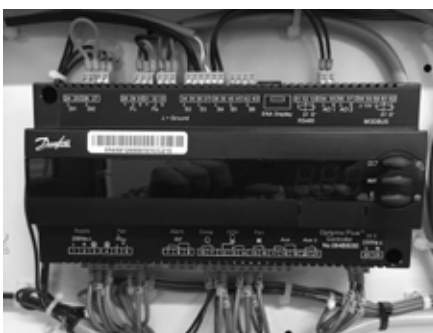
Bild 3: Normale Verdrahtung
