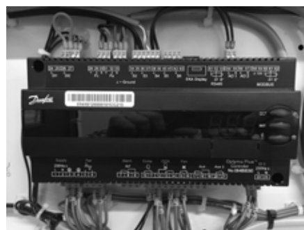
Bilde 3: Normal kabling
