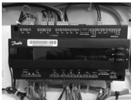
Billede 3: Normal ledningsføring
