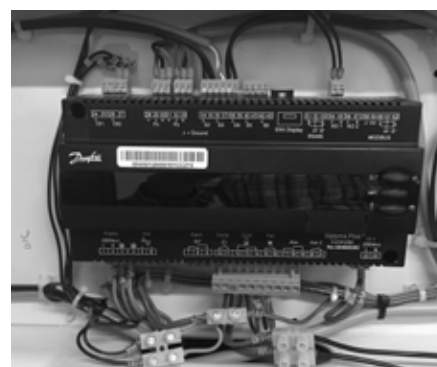
Rysunek 4: Okablowanie tymczasowe
