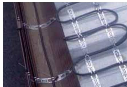
Трос або монтажна стрічка у верхній частині мають бути надійно прикріплені до конструкції будівлі. Якщо довжина труби не перевищує 3-4 м, кріплення можна використовувати і без троса/ланцюга. Кріплення рекомендується встановлювати по 3-4 шт. на метр довжини. При виборі способу кріплення потрібно враховувати гальванічну сумісність матеріалів водостоків і елементів кріплення.
