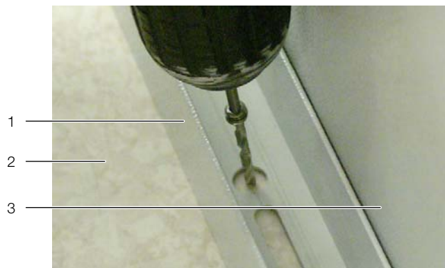
Рис. 8: Сверление крепежных отверстий
