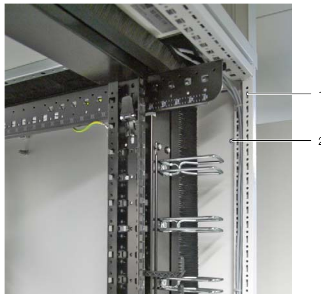
Рис. 10: Крепление боковой стенки
