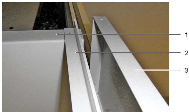
Рис. 53: Уголок крыши над дверью отделения коридоров
